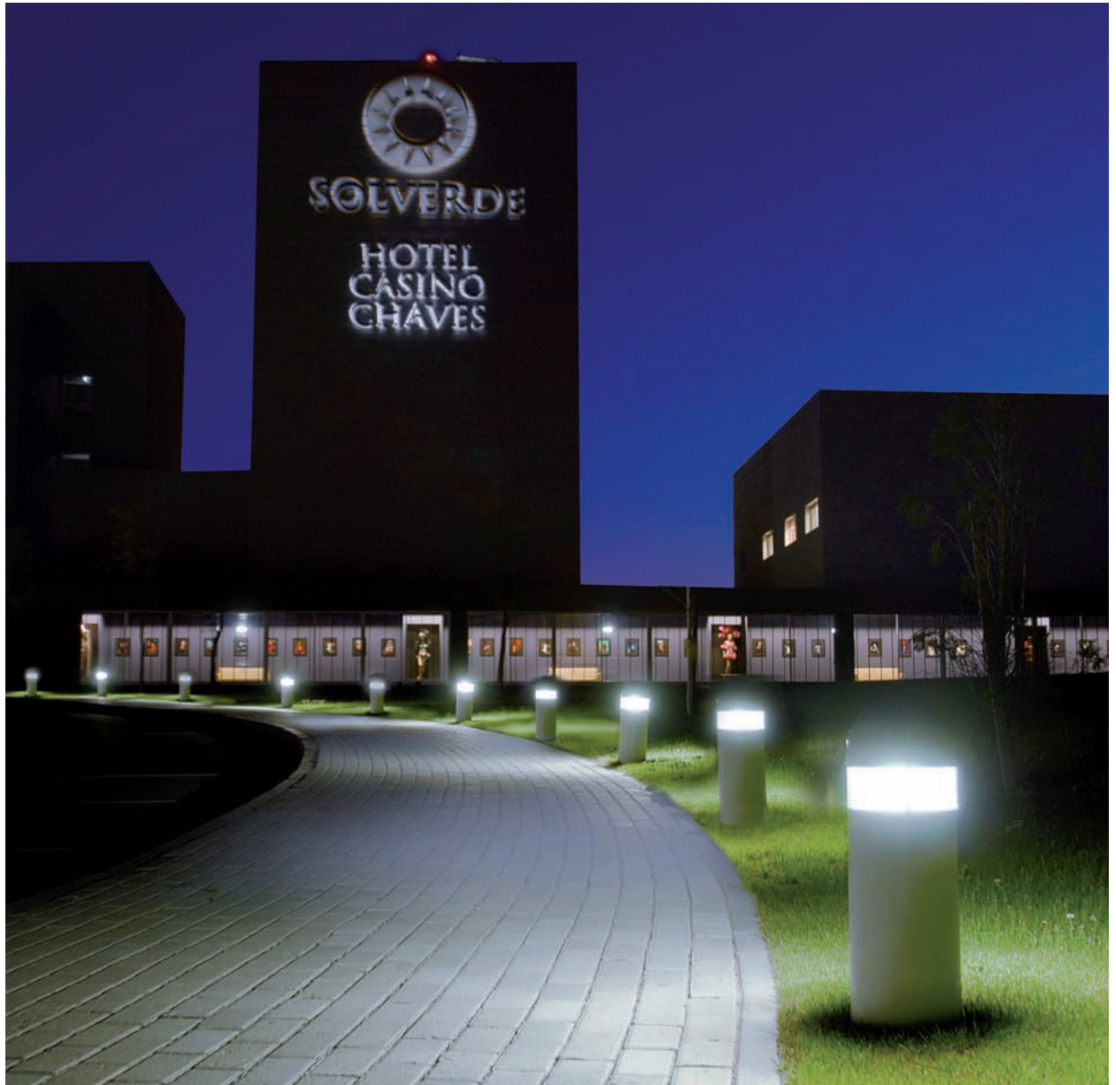
CASINO DE CHAVES - Portugal Architetto - Rui Lacerda
