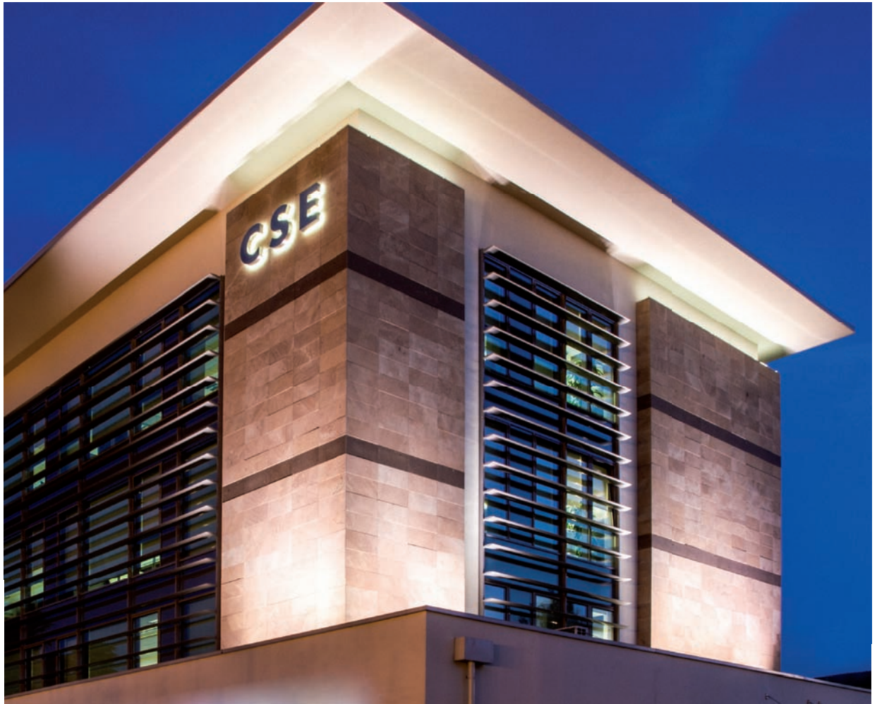
Centro Direzionale - Bologna Project - Venturelli Arte e Luce
